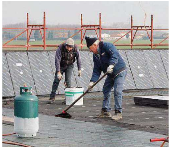
Operai lavorano alla costruzione della scuola a Fornacette
