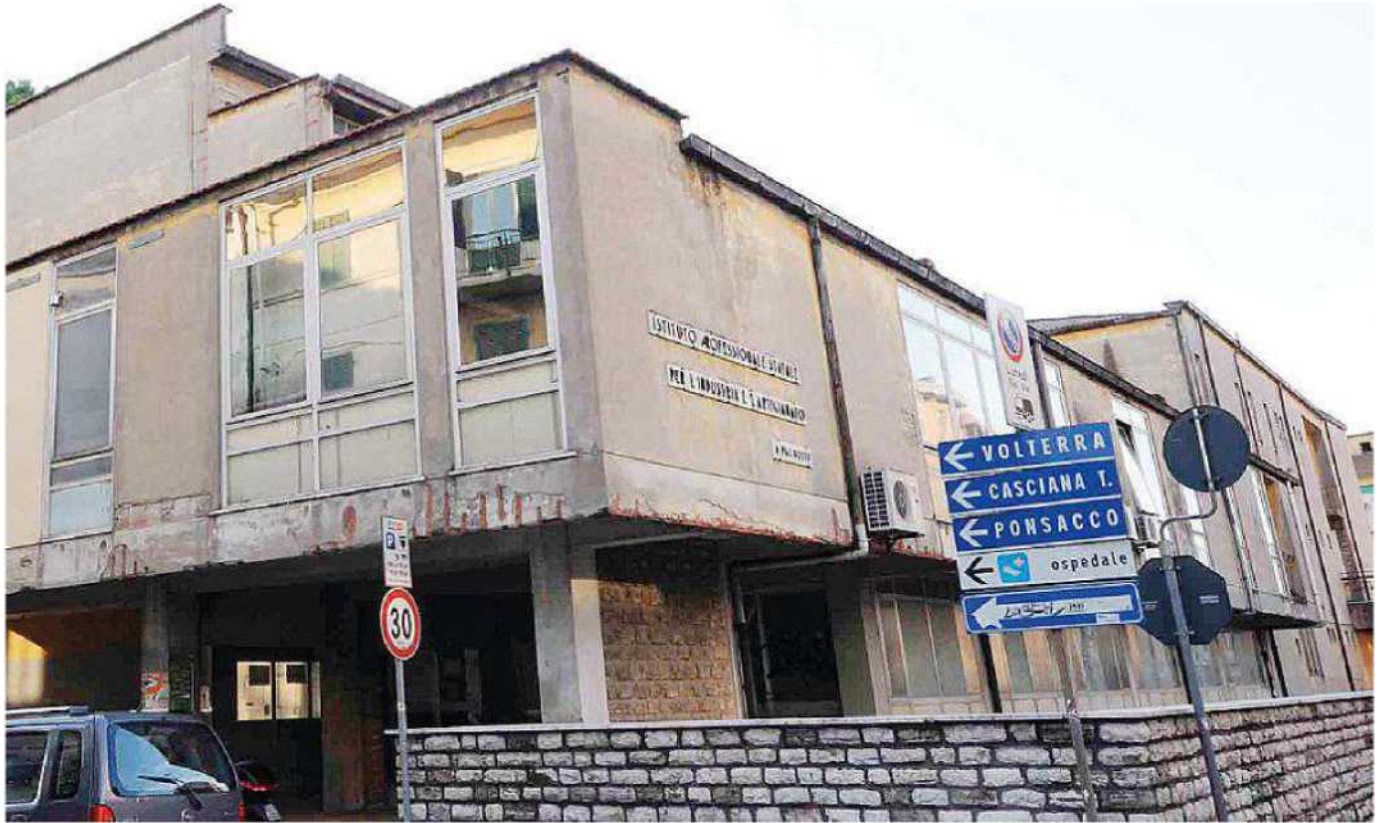
L'immobile dell'ex Ipsia a Pontedera (Foto d'archivio)
