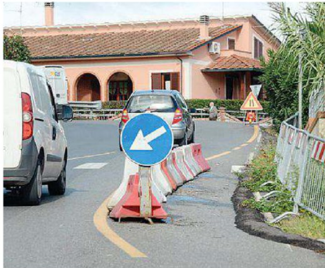
Restringimento di carreggiata in San Michele a Santa Maria a Monte
