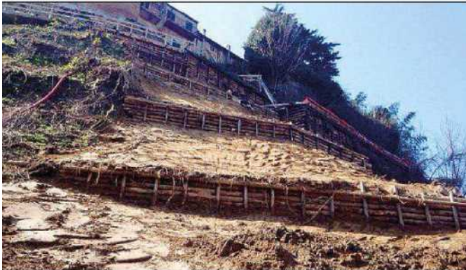
Lavori per mettere in sicurezza una frana a Palaja
