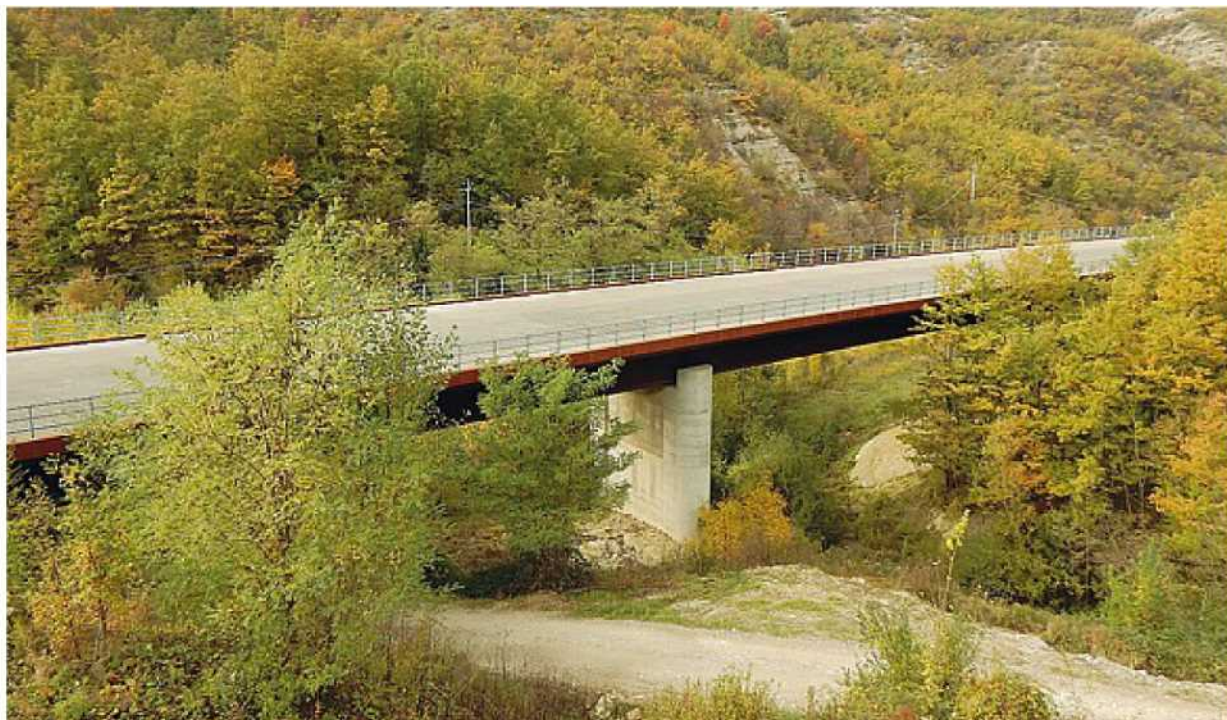
Un cavalcavia sul lato marchigiano della galleria della Guinza, a Mercatello sul Metauro. Il cantiere è fermo da anni e la strada finisce in un campo
