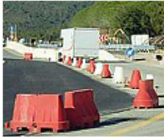
Uno dei cantieri sulla Grosseto-Siena
