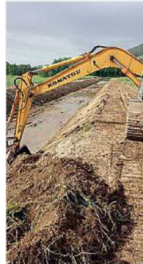
Lavori a Vicopisano
