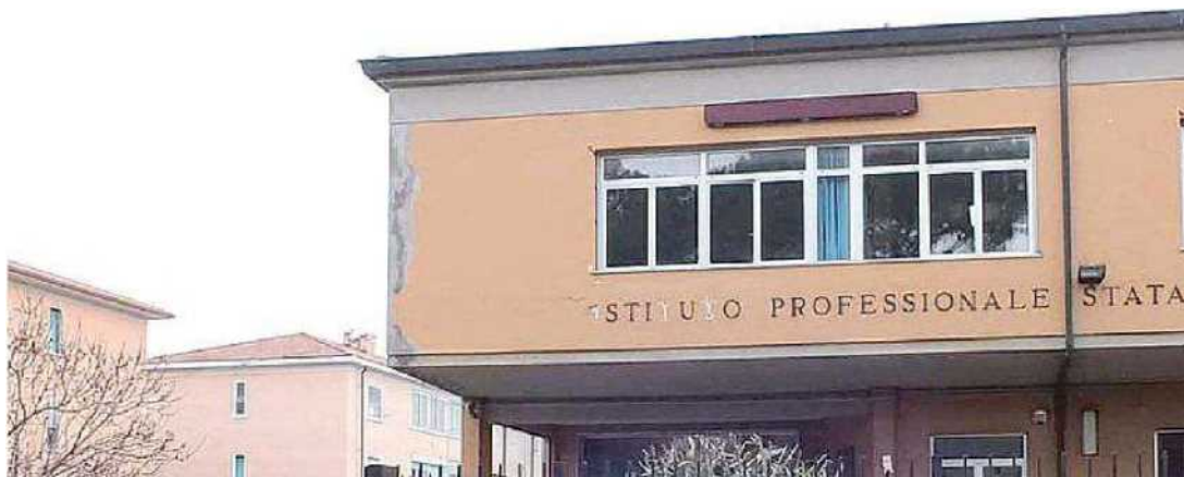
L'edificio che ospita l'istituto professionale Fascetti a Pisa
