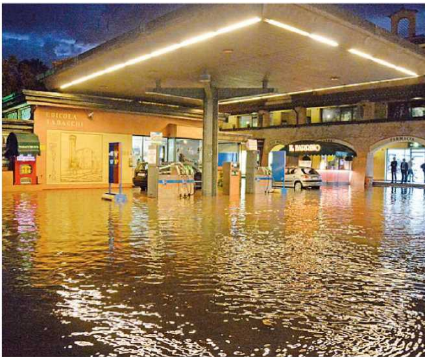
Il distributore del "Centro Torretta White" completamente allagato
