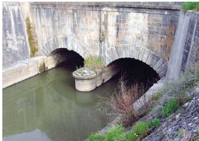
Il Canale Emissario (foto di repertorio)
